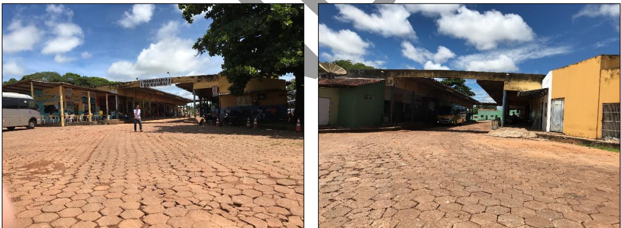
Foto 3. Terminal Rodoviário de Guarai.
